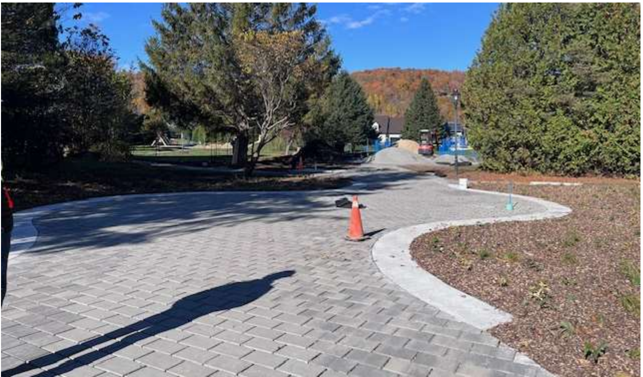
Figure 11 : Aperçu de la passerelle aménagée
