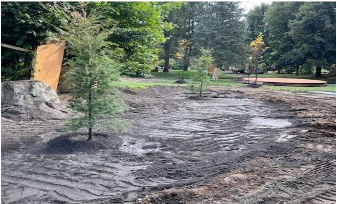
Figure 9 : Réalisation des travaux d'aménagement
